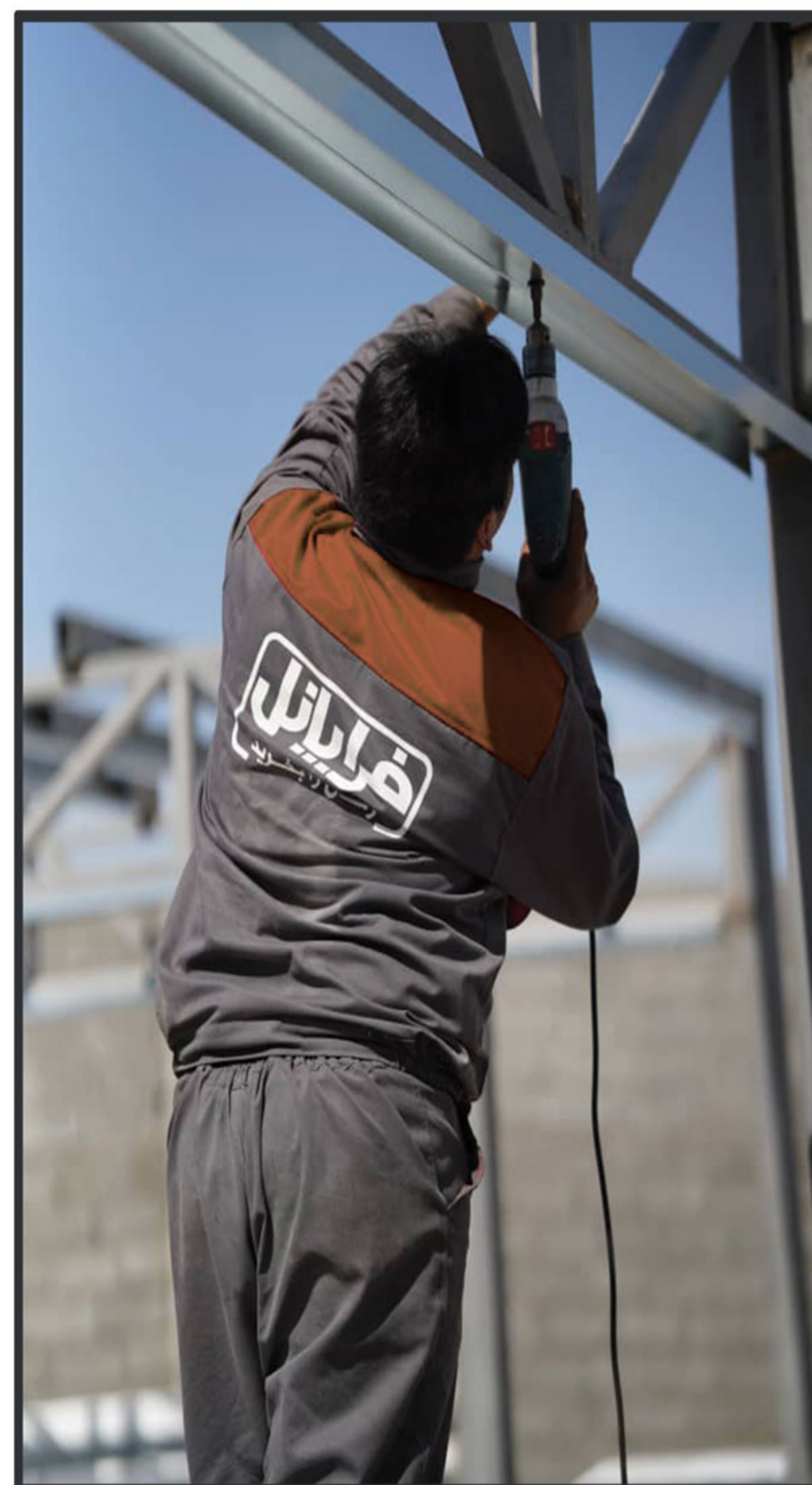
۲ نصب رانر در زیر سقف دقیقاً به موازات رانر کف
