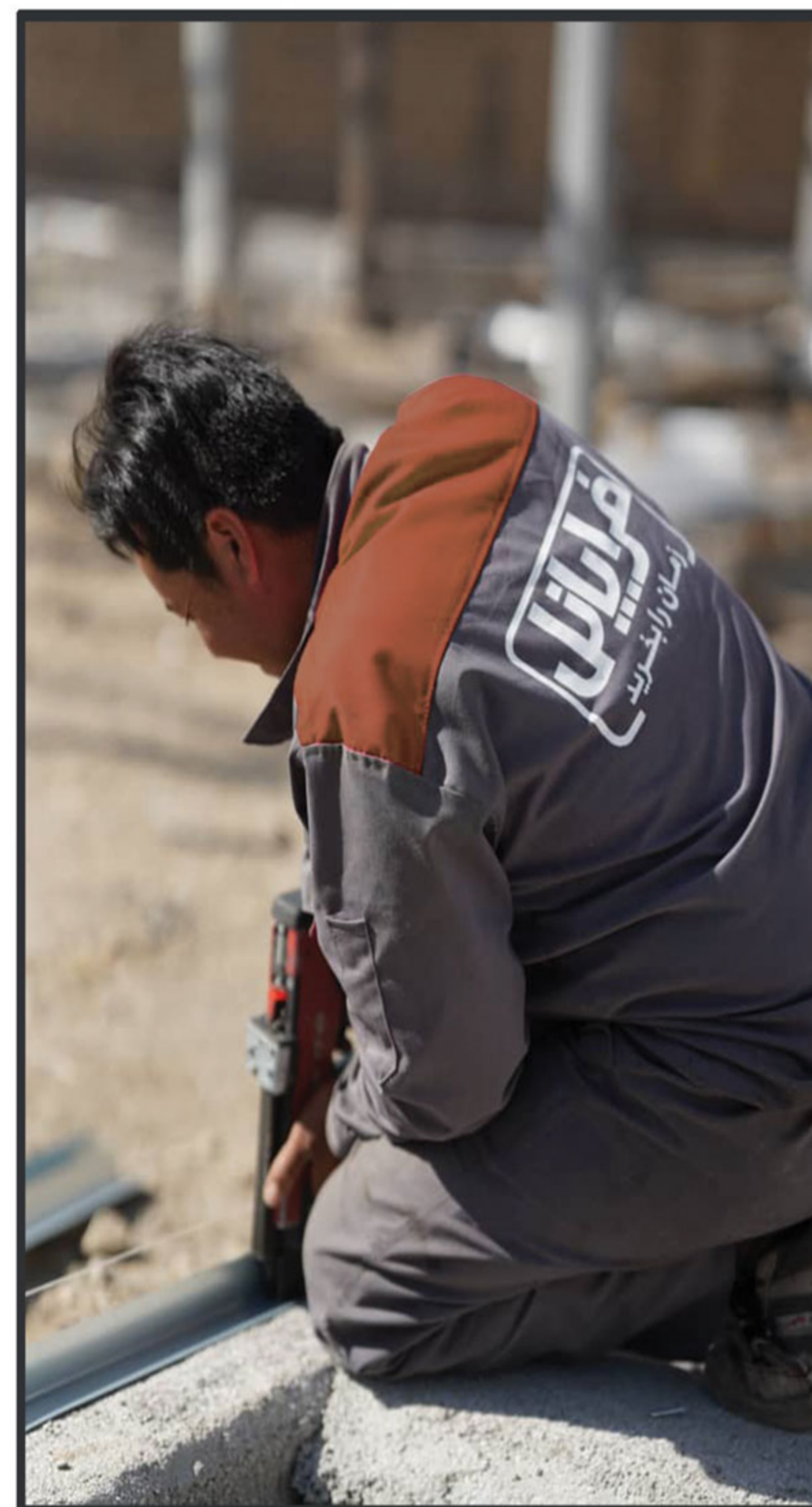
۱ نصب رانر در کف و بر روی بتن
