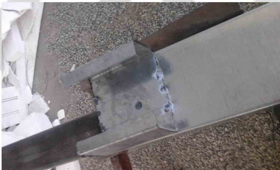
شکل ۲-۴ اتصال ناودانی به وسیله نقطه جوش به استاد
