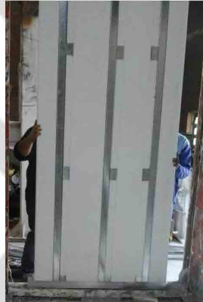
شکل ۳-۴ قرار گرفتن پانل در داخل رانر بصورت کشویی شکل ۴-۴ اتصال رانر و استاد به نبشی بالایی
