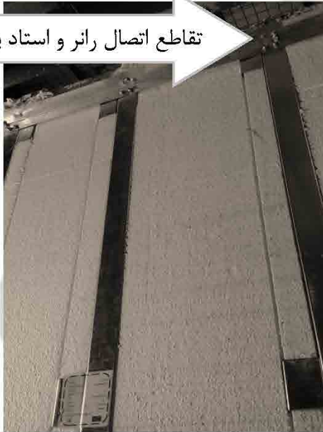
شکل ۳-۴ قرار گرفتن پانل در داخل رانر بصورت کشویی شکل ۴-۴ اتصال رانر و استاد به نبشی بالایی
