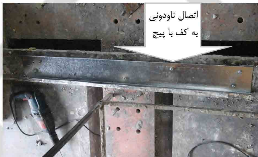
شکل ۴-۱ اتصال رانر ناودانی به کف
